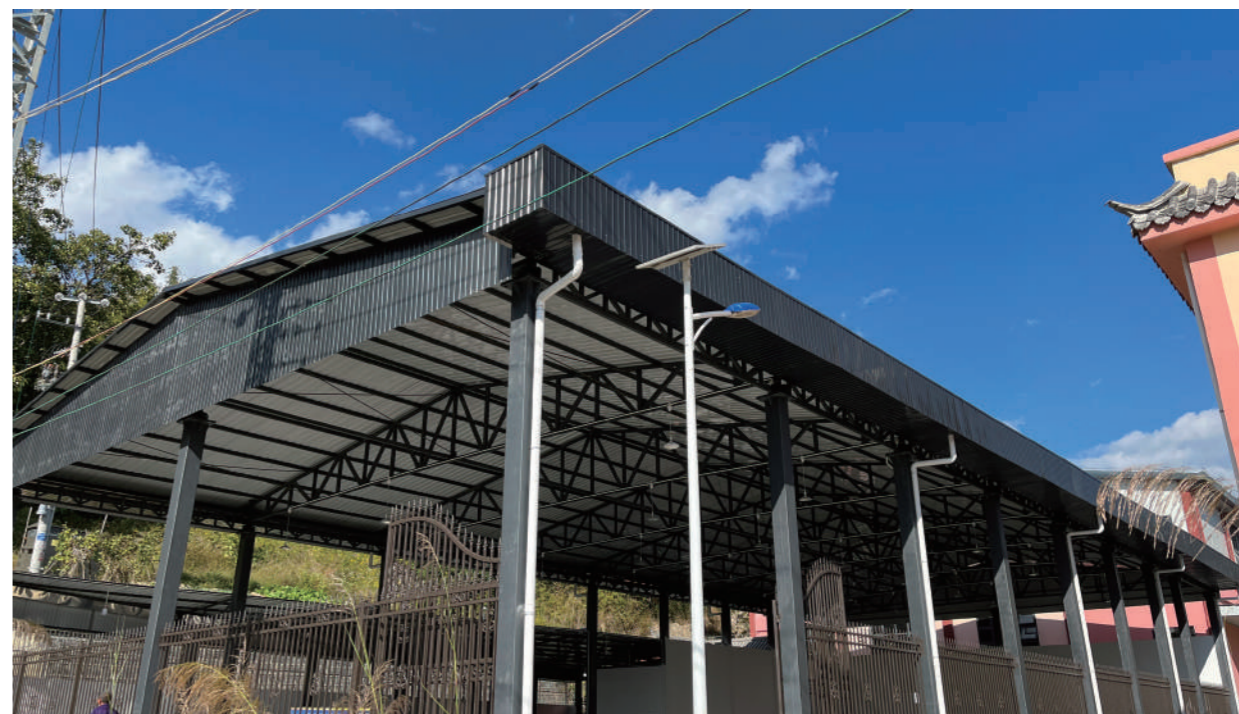
建设梁河县平易村村民活动中心
