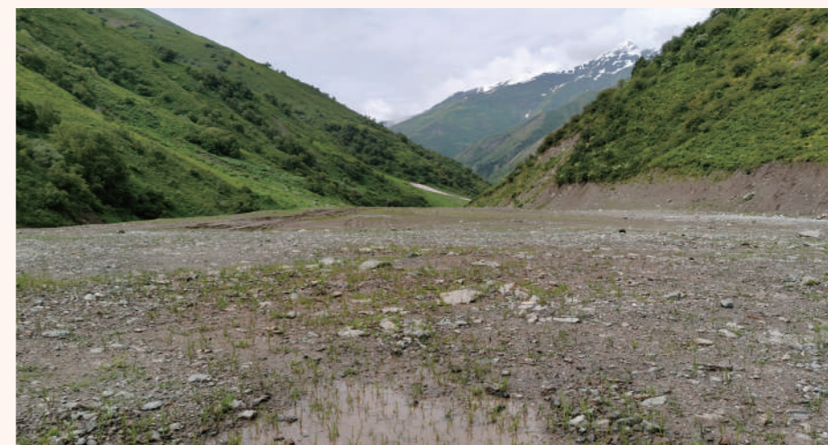
中色国矿帕鲁特公司对临时干排尾矿库进行覆土、洒种草籽绿化
